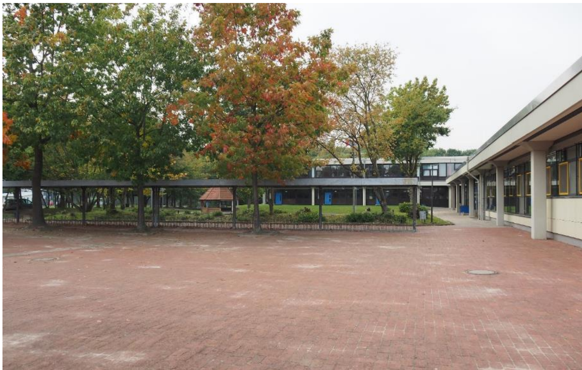
Abbildung 29: Überdachte Fahrradständer auf dem südlichen Schulhofteil der Selma-Lagerlöf-Oberschule
